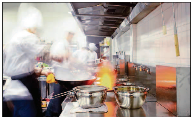
Sobald die Dämpfe draussen sind, schaltet die Lüftung zurück.
